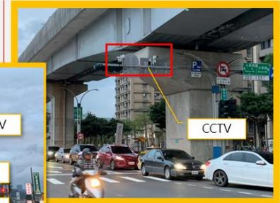
設備布設規劃：萊康號誌控制器、電力、箱體、通訊、RSU（箱體內，預計約 7m Cable 延伸至天線）、智慧號誌桿、英研 CCTV（人流）
