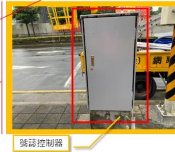
設備布設規劃：山疇號誌控制器、電力、箱體、通訊、AI CCTV(人流)、既有 RSU、CMS、雷達
