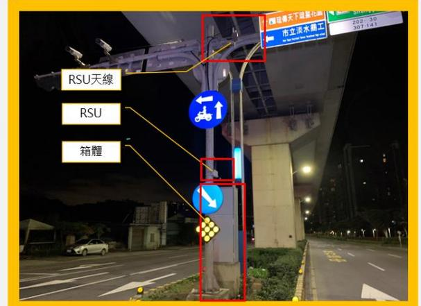
設備布設規劃：良基號誌控制器、電力、箱體、通訊、RSU
